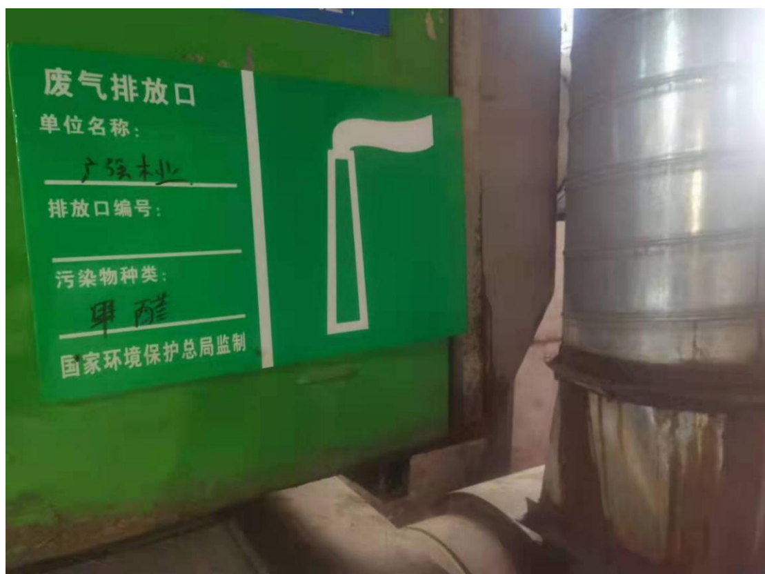
排气筒已悬挂标识牌
