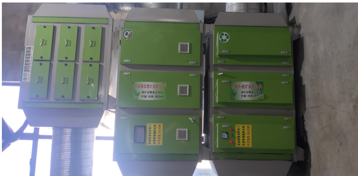
水喷淋+静电除油+光氧催化+活性炭装置
